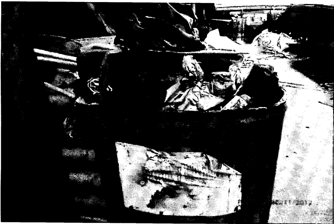
Foto 8: Acopio de los residuos de obra sin actividades de separación en la fuente con posible presencia de residuos especiales y de tipo peligroso.
