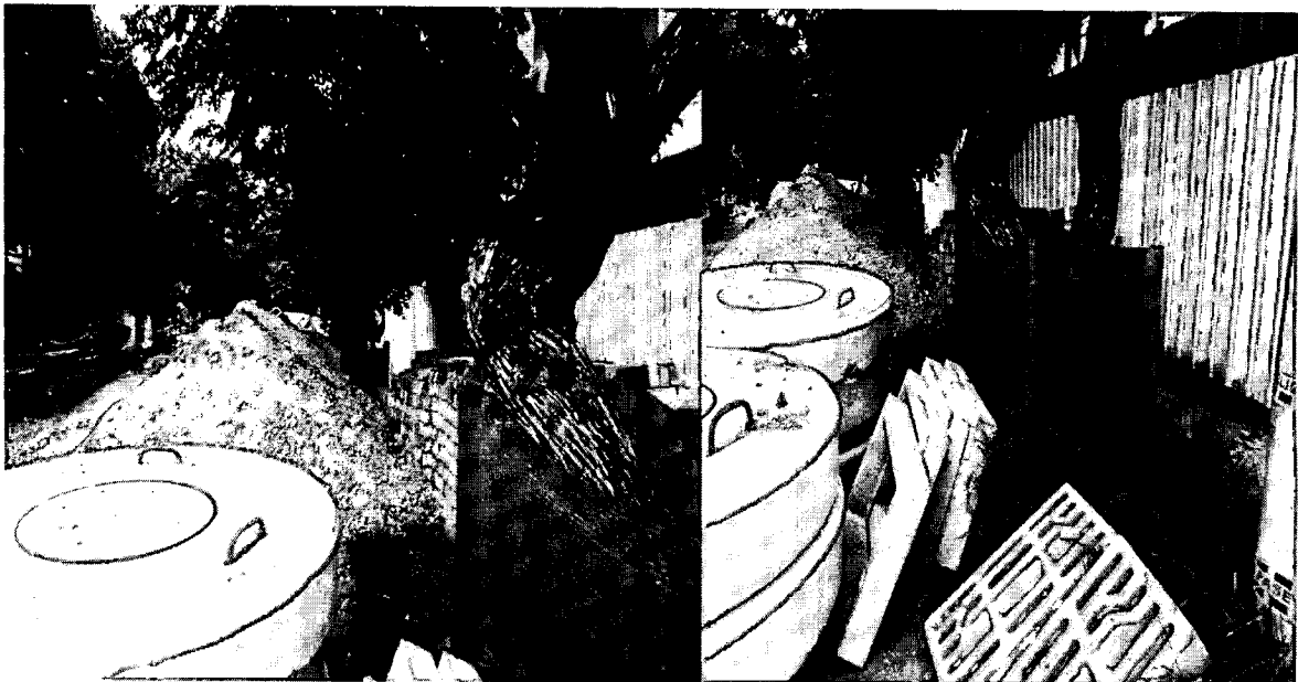
Fotos 13 y 14: Acopio de materiales sobre el fuste de árboles y en zonas verdes (ver el material de cantera derramado sobre el árbol y zonas blandas).
